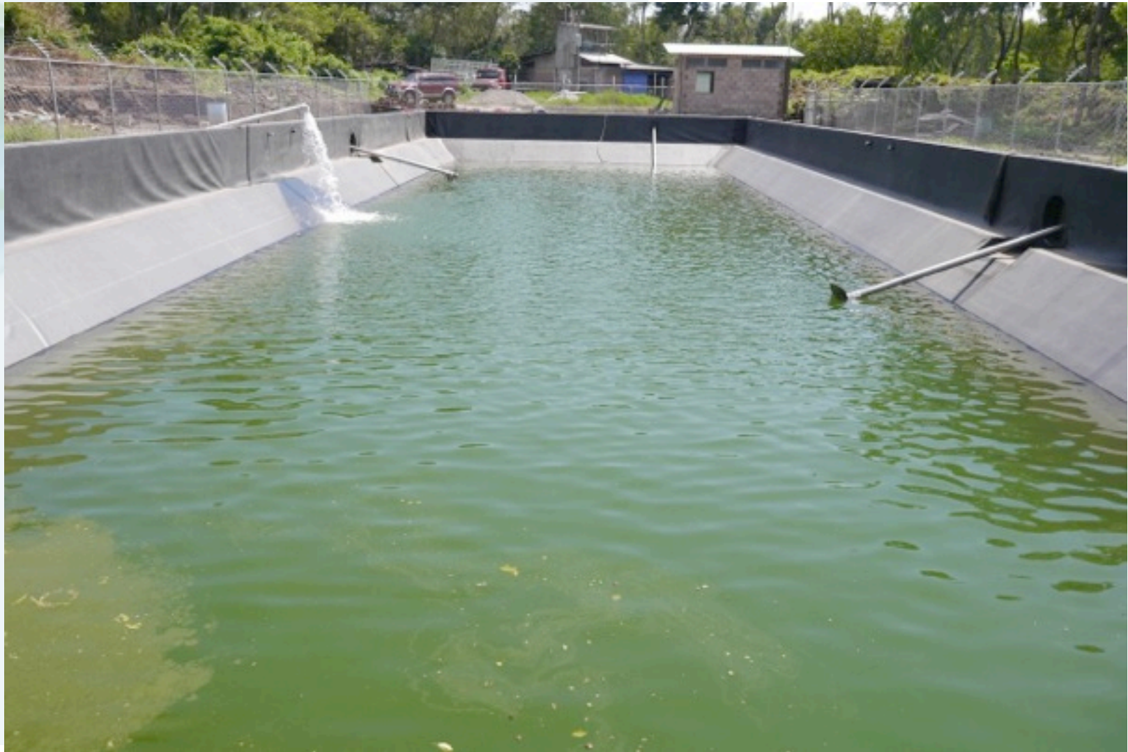
Llenado de laguna de biodigestor para pruebas de estanqueidad
