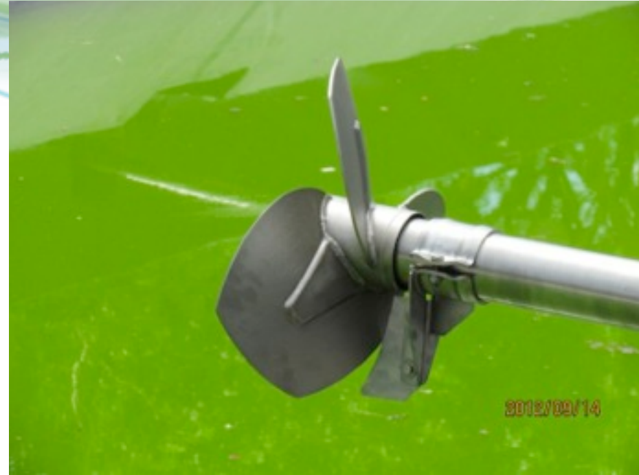
Instalación de agitadores
