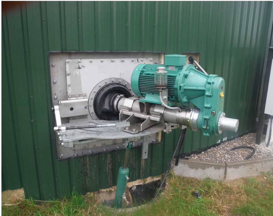
Instalación en biodigestor sobre tierra tipo tanque
